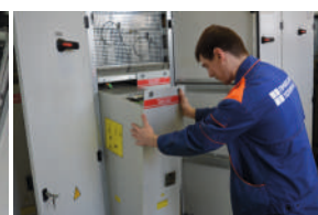
Установка модуля МТ1000
